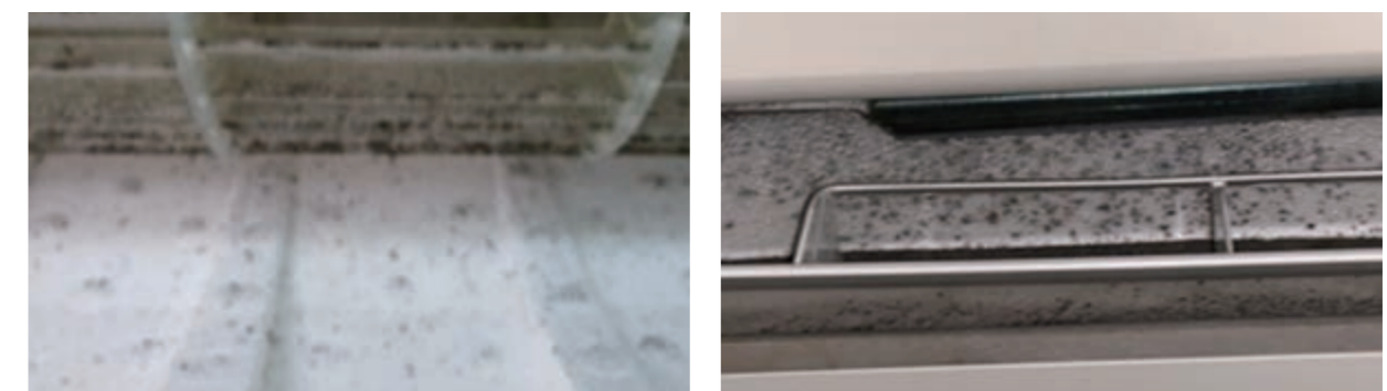
Przykład przypadku zanieczyszczenia EPS.
